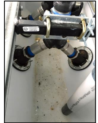
Fig. 8 - under dispenser containment (UDC)
